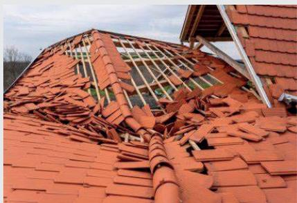
Pan de couverture arrachée tuiles arêtières et partie courante arrachées
