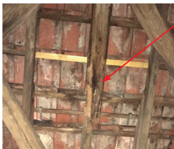
Infiltrations latentes par suite de bris de tuile
