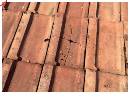
Infiltrations latentes par suite de bris de tuile
